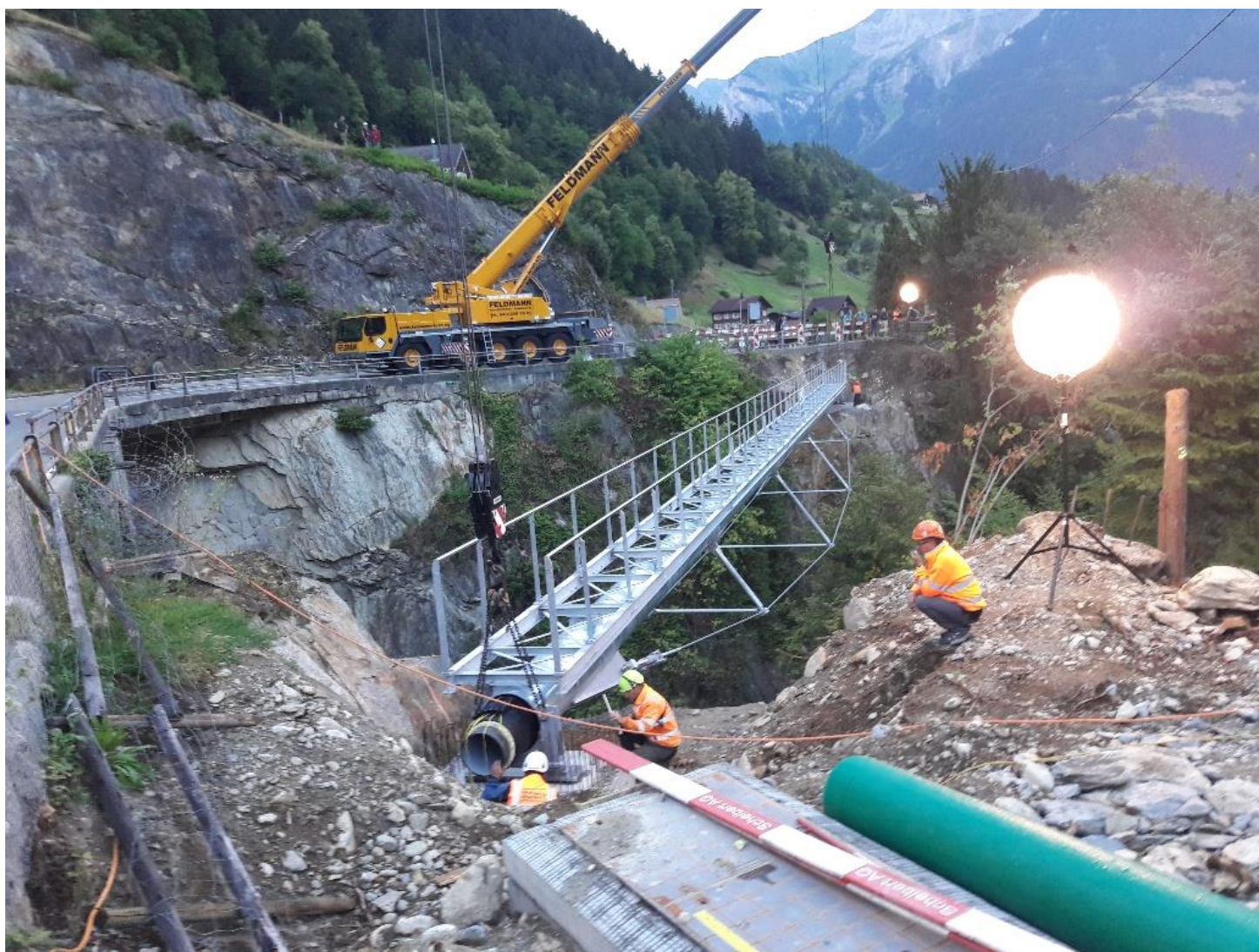
Bild Abwasser Uri: Montage begehbare Rohrbrücke Intschialpbach (Ableitung Abwässer Urner Oberland)
