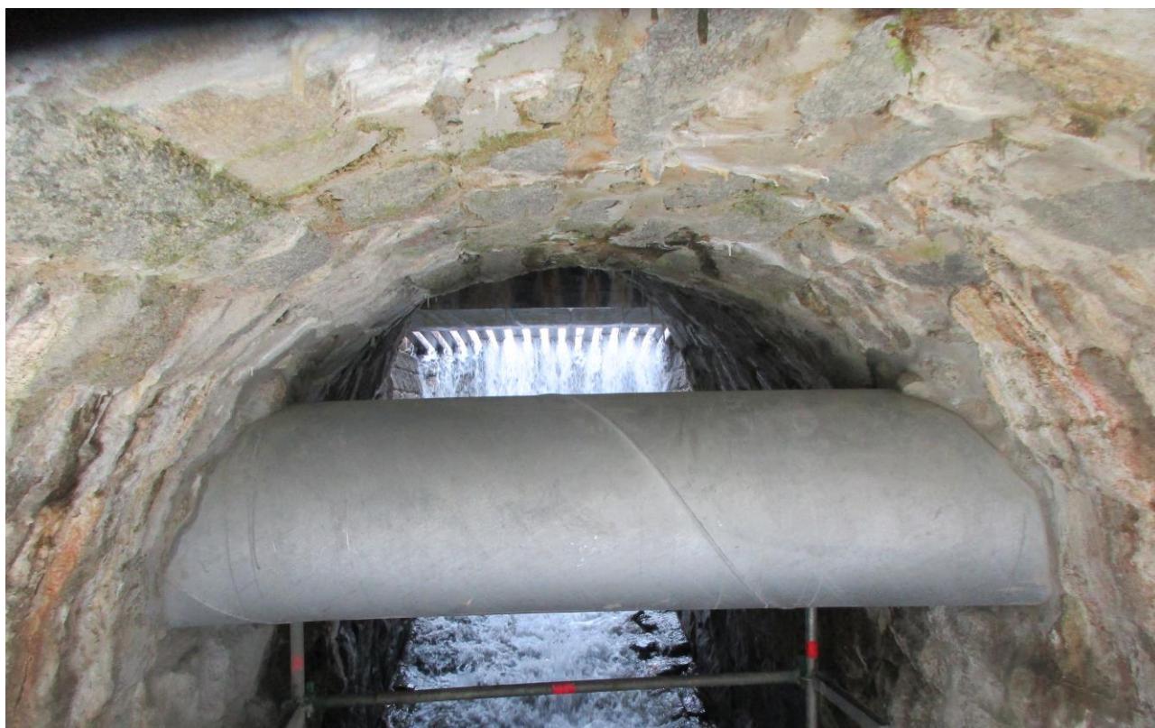
Bild Abwasser Uri: Querung Standelbach zwischen Göschenen und Wassen (Ableitung Abwässer Urner Oberland)
