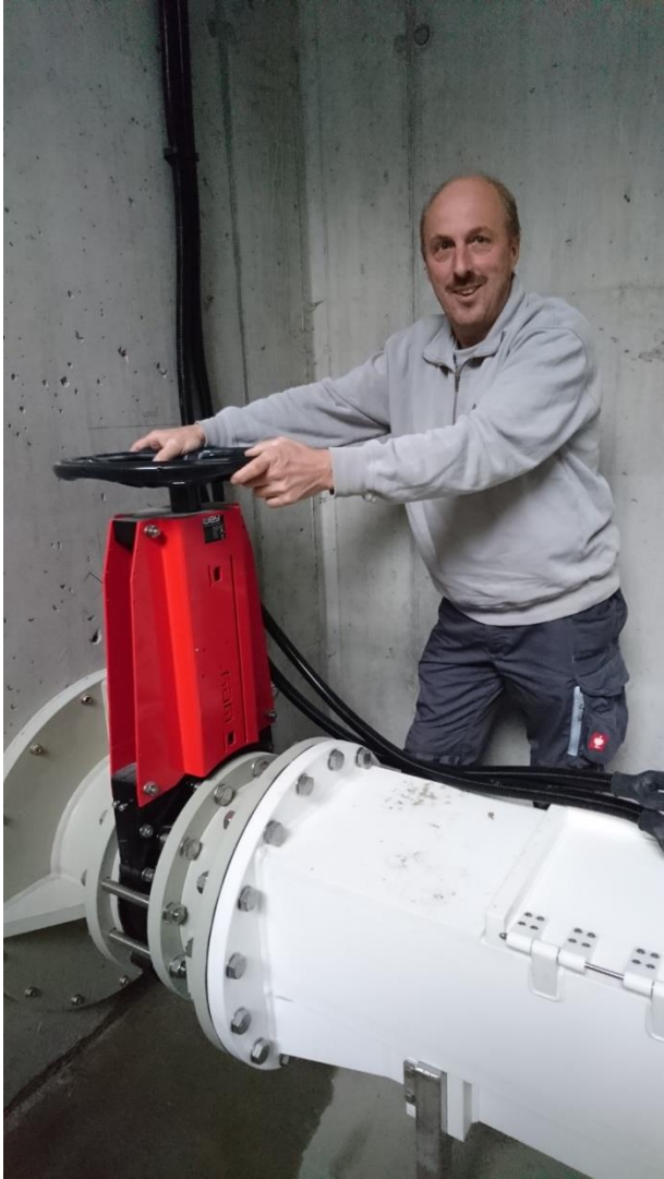
Bildlegende: Bärli Baumann öffnet den Schieber der Ableitung und nimmt damit die ARA Wassen ausser Betrieb.
