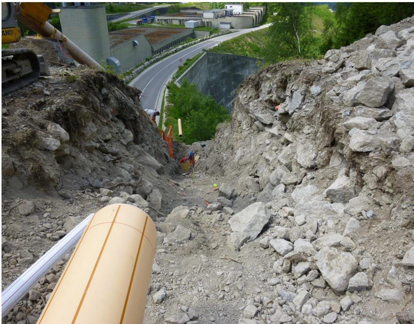
Bild Abwasser Uri: Spektakulärer Leitungsbau beim Umfahrungstunnel Steglai in Göschenen (Ableitung Abwässer Urner Oberland)
