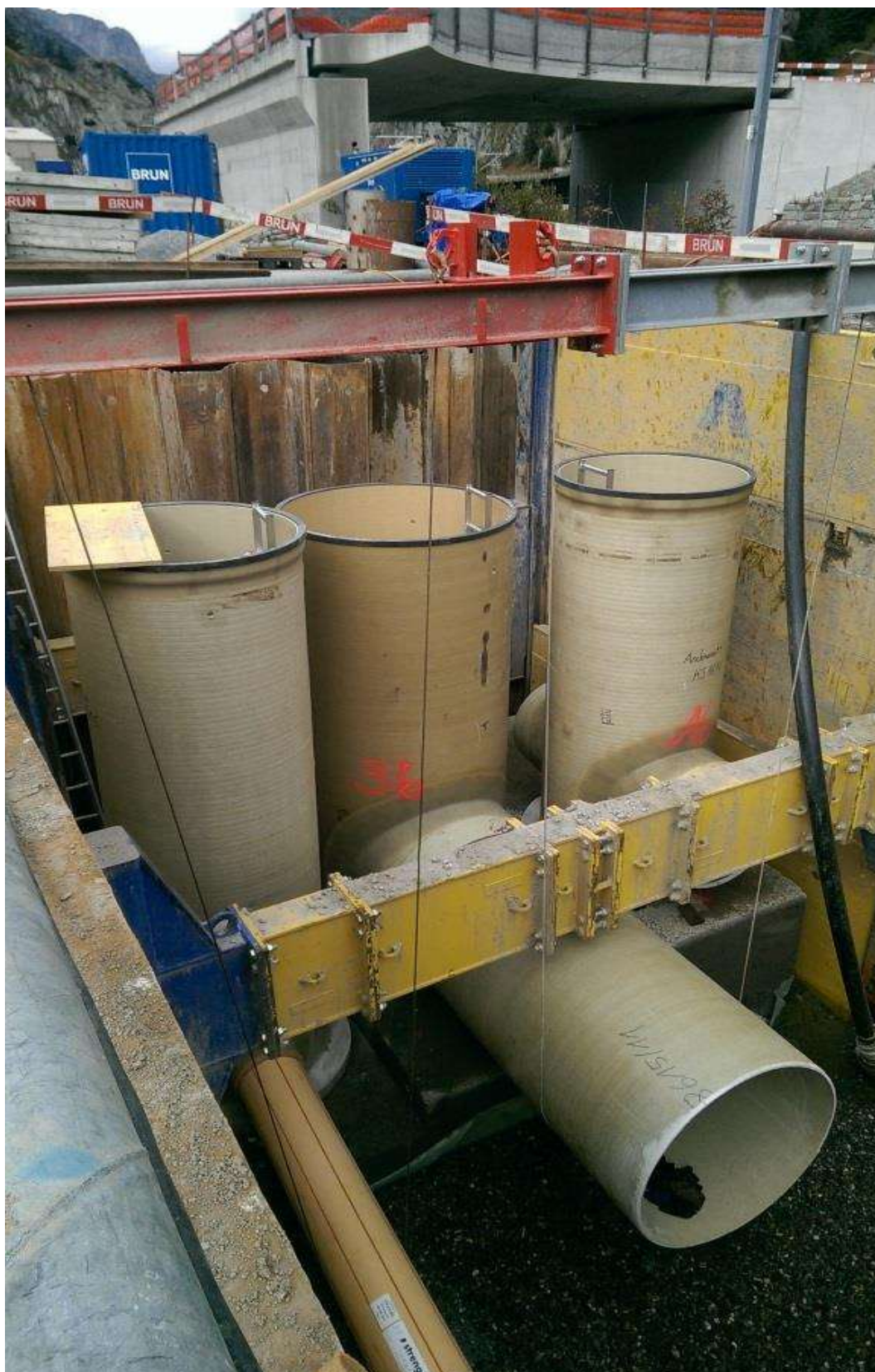
Bild Abwasser Uri: Leitungsbau Andermatt Eiboden Ost
